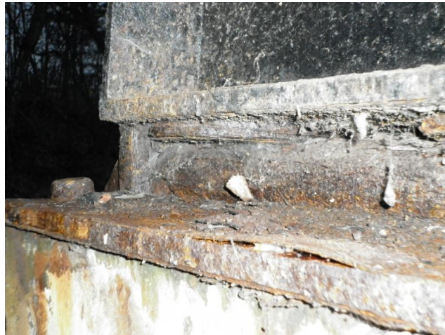
Fot. 11 rozwarstwienie blachy stopowej
