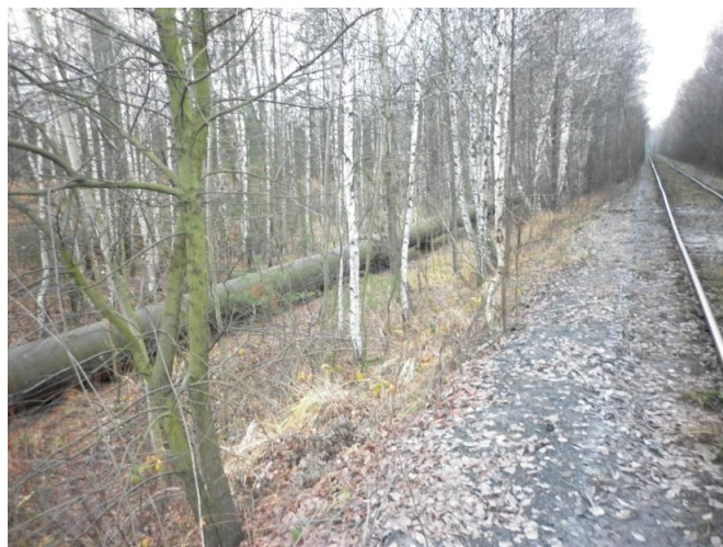
Fot. 1 przebieg rurociągu.
