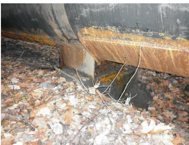
Fot. 8 wzmocnienia blachą
